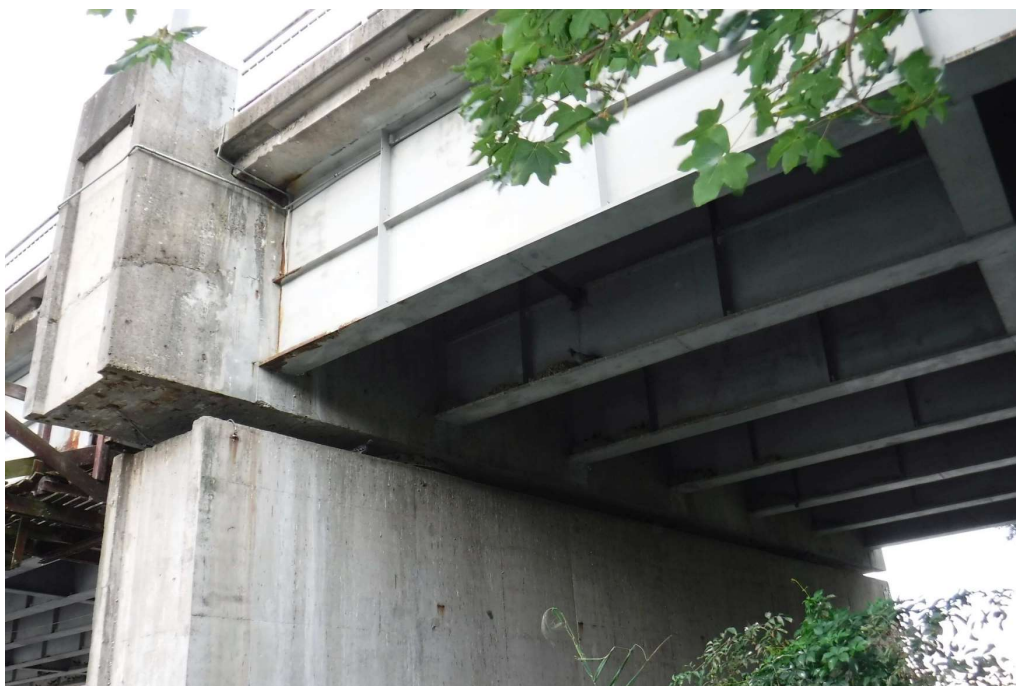
Obrázek č. 5: Podhled NK v prvním mostním poli – patrný je tvar nosníků i tvar nadpodporového příčnicku
