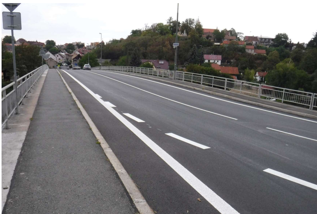
Obrázek č. 6: Šířkové uspořádání na mostě – pohled proti směru staničení
