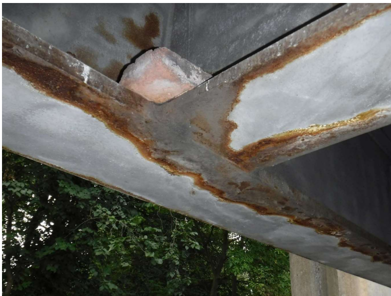
Obrázek č. 28: Koroze nosníku a příčnicku při zkušebním místě č. 1
