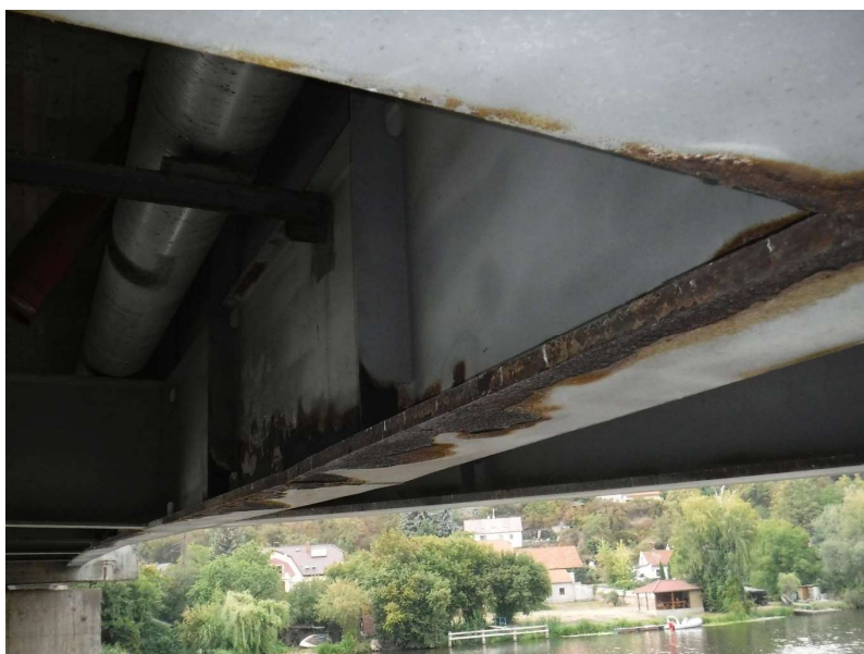
Obrázek č. 30: Koroze nosníku při zkušebním místě č. 3
